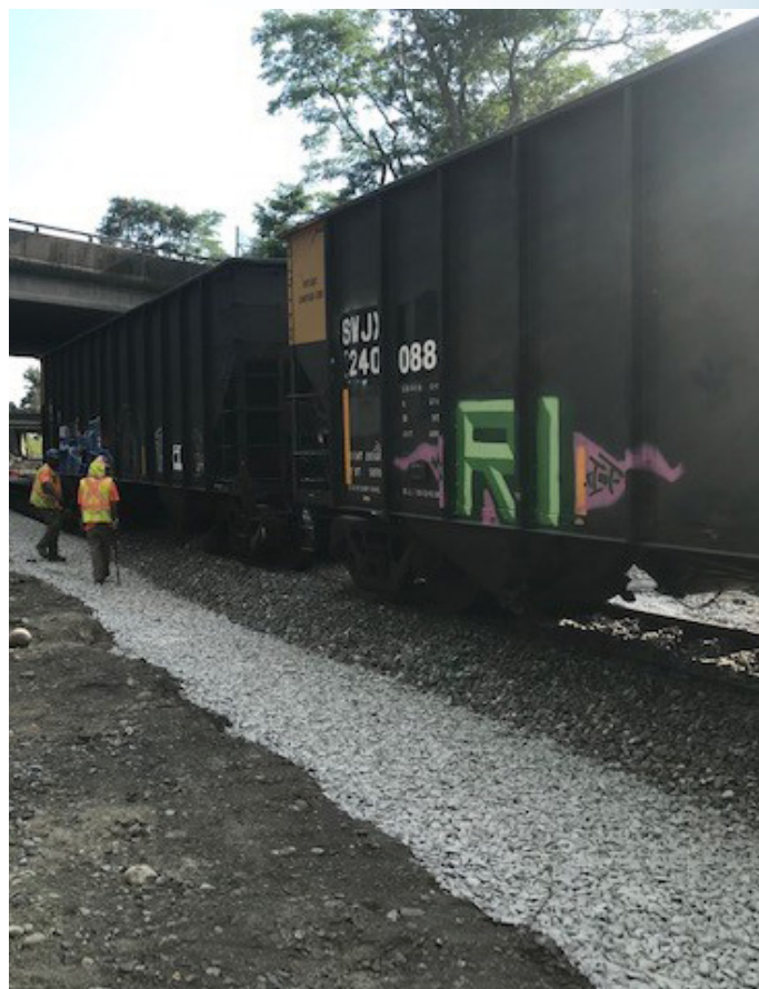
Traslado del balasto en vagón de tren al puente de Route 79
