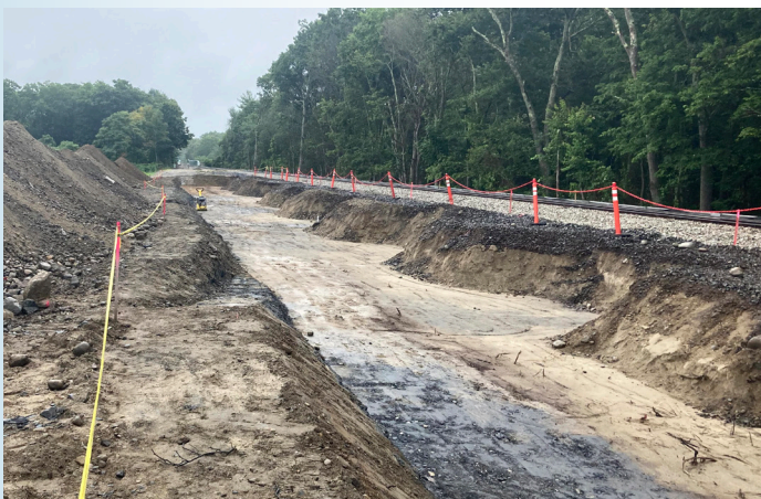
Preparación de la obra de Freetown Station
