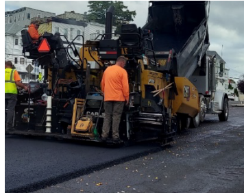
Repavimentação de trechos danificados da rua
