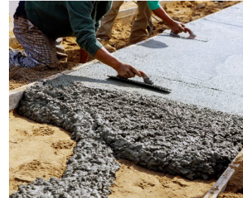
Reparos da calçada
