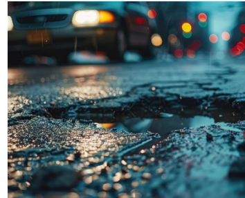
Reparo de buracos
