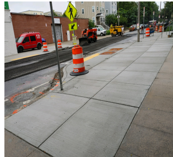
Reparos das calçadas
