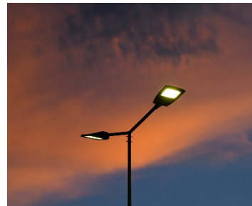
Melhoramento da iluminação pública
