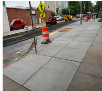
Via Hè Được Sửa Chữa
